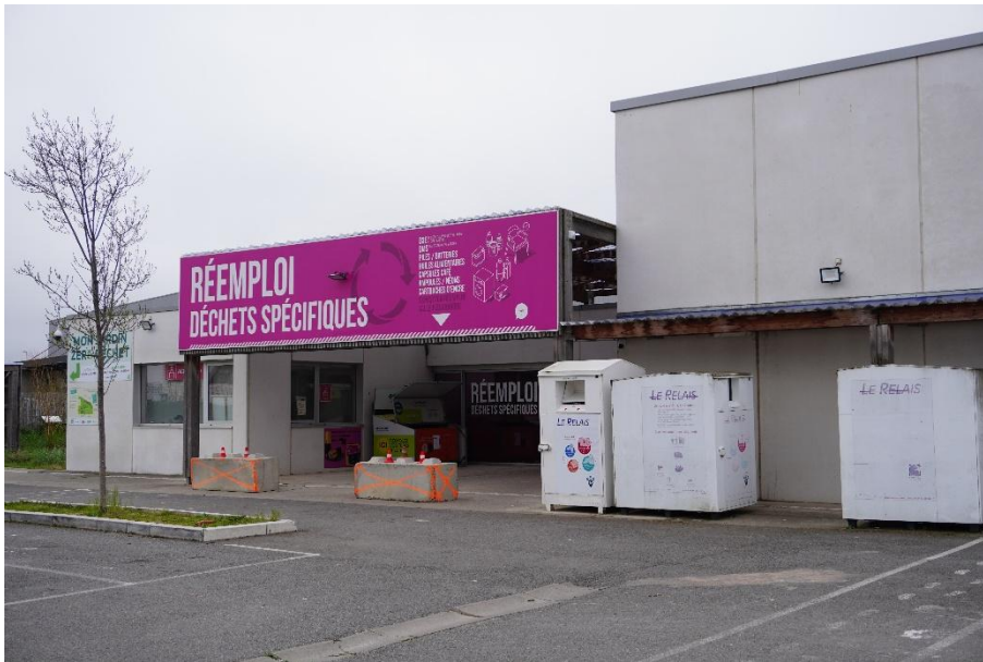
Déchèterie de Plaisance-du-Touch
