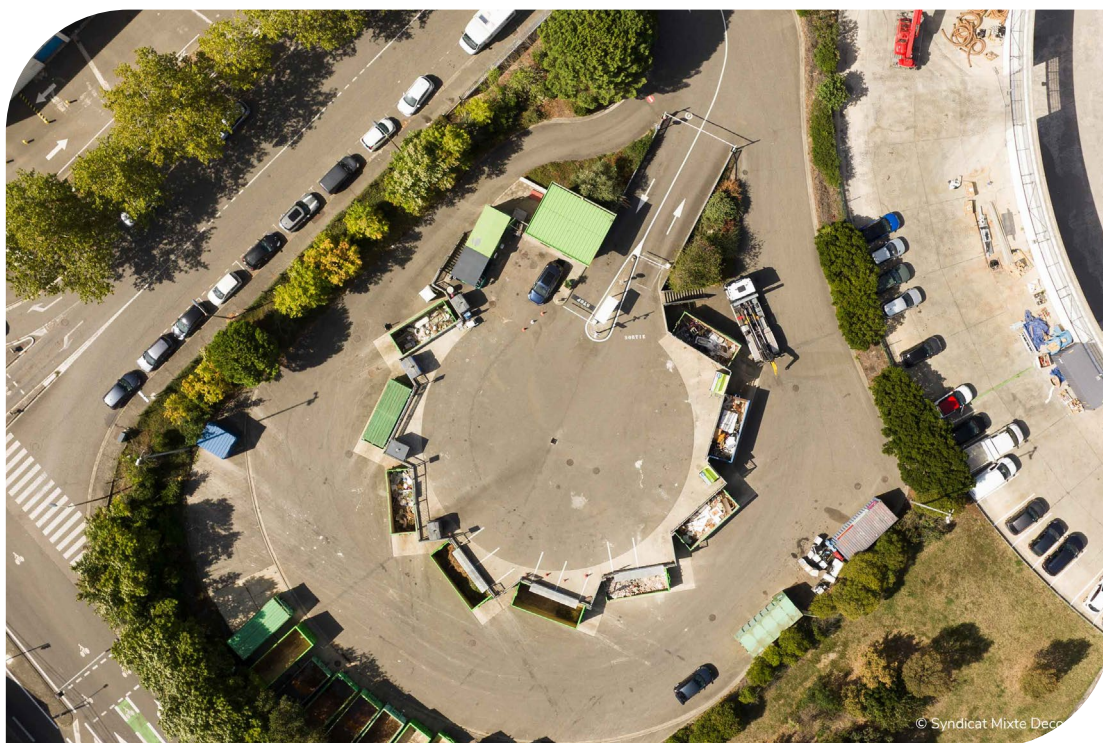
Figure 9 - Vue aérienne déchèterie Decoset.
