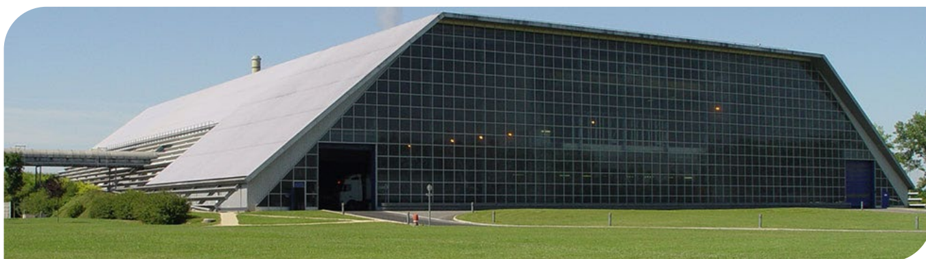
Figure 6 - Unité de Valorisation Energétique de Bessières.
