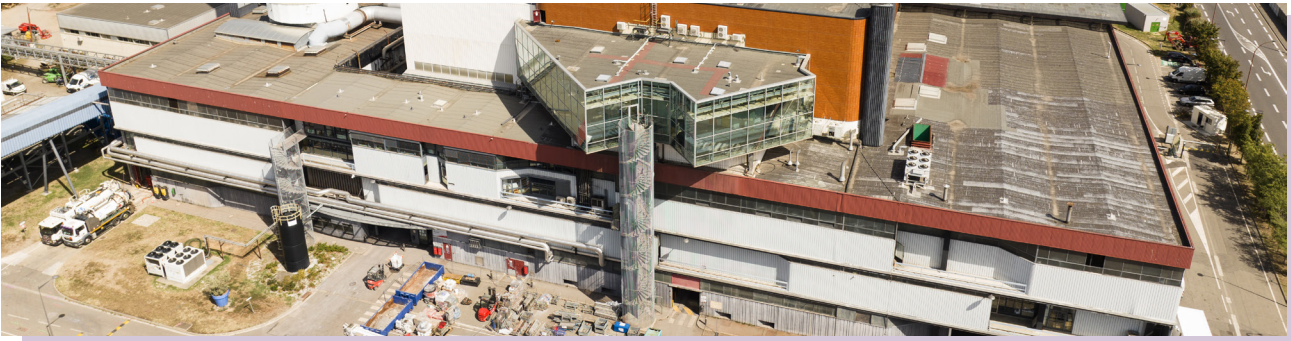
Unité de Valorisation Énergétique de Toulouse
