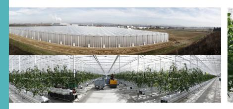
Chaque pied de tomate peut mesurer jusqu'à 15 mètres. L'objectif annuel de production est de parvenir à 64kg par mètre carré. Installation de haute technologie, les serres font l'objet d'un pilotage informatisé des entrants et de la gestion de l'eau. La pollinisation est assurée par des bourdons, et la lutte biologique contre les nuisibles et les maladies est privilégiée.
